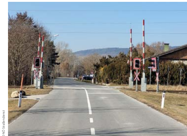
Technische Sicherung einer Eisenbahnkreuzung mit Schranken und Lichtzeichen
