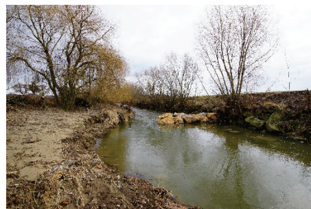
Strukturierung Mank Unterlauf (Huchen) © WA3, J. Nesweda
