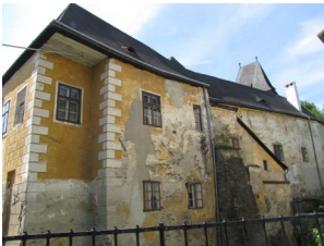
Schloss Pöggstall – Teil der Fassade vor der Sanierung
