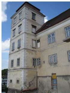
Stift Lilienfeld – Turm vor der Sanierung
