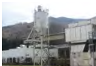
Der bisher deponierte Filterstaub wird nun einer Verwertung zugeführt. Dazu war die Anschaffung eines Silos samt Fördersystem erforderlich. Foto: Georg Fischer Fittings GmbH
