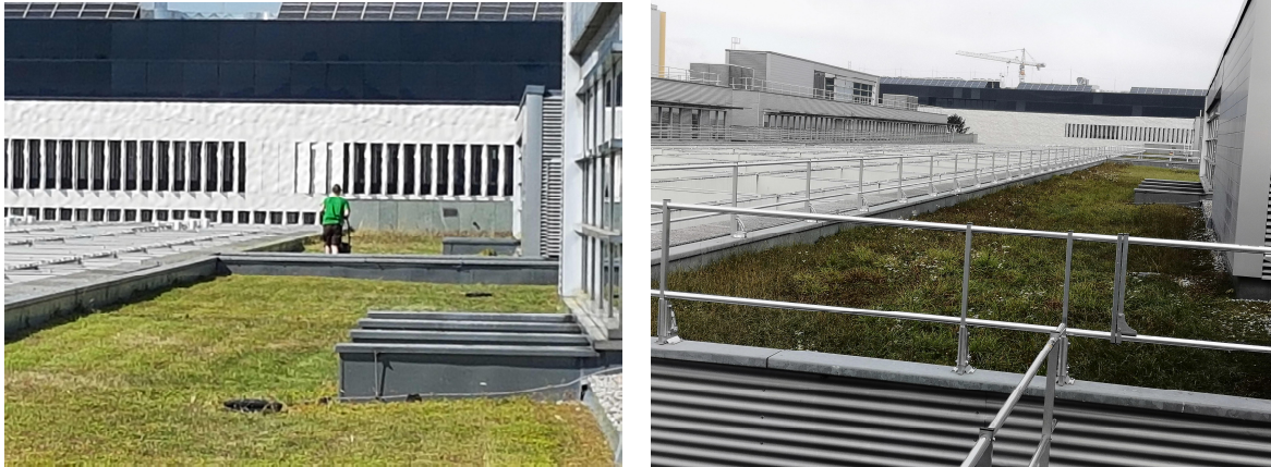
neu angebrachte Absturzsicherung
