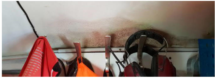
offene Kabelauslässe und Schimmelbefall im Mannschaftscontainer
