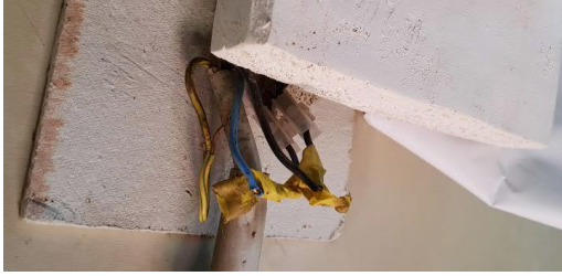
offene Kabelauslässe und Schimmelbefall im Mannschaftscontainer
