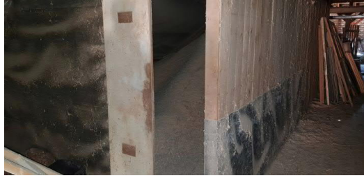
Die „Einhausung“ am Dachboden
