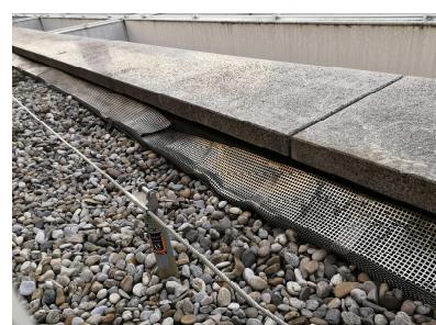
neu angebrachte Anschlagpunkte
