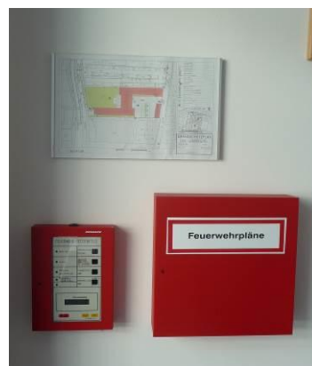
Feuerwehrbedienfeld mit Plankasten
