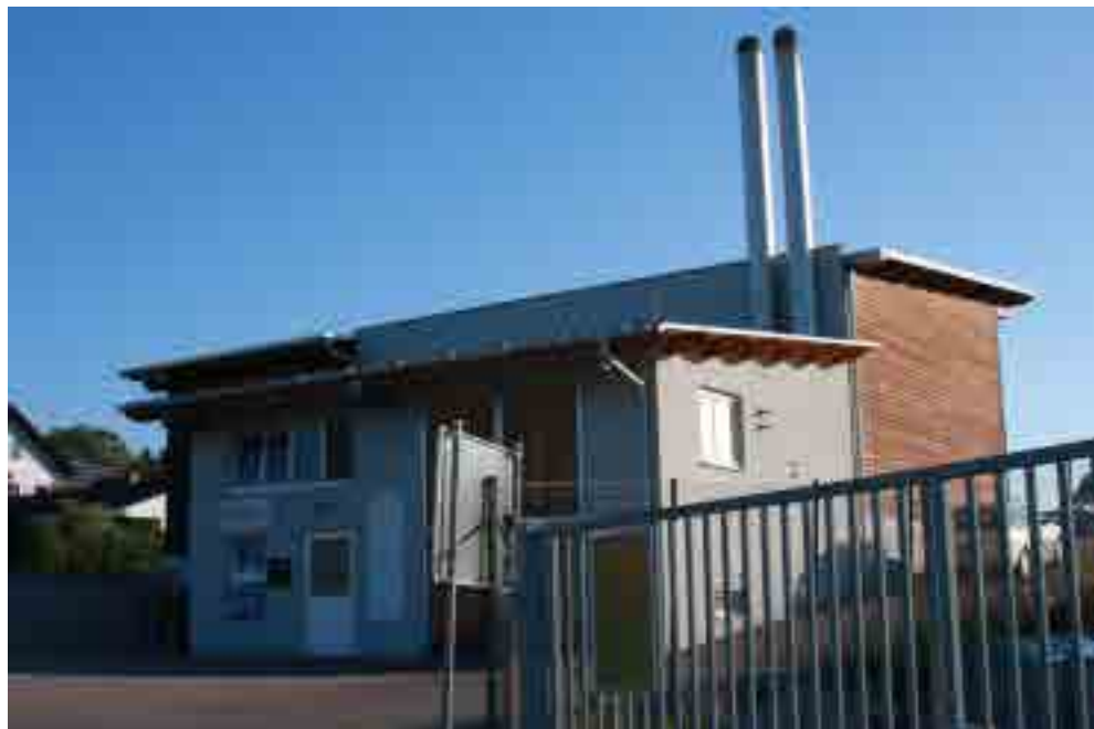
Biomasse-Nahwärmanlage Maria Laach/Jauerling; Copyright: Josef Petschko
