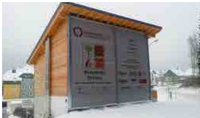
Biomasse-Nahwärmanlage Gaming II zur Ortskern-Wärmeversorgung des Ortes Gaming
