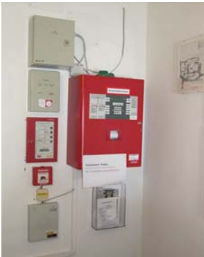
Brandmeldeanlage – Zentrale
