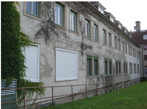
Alte Fassade mit neuen Fenstern, Übersicht
