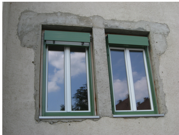
Alte Fassade mit Fenstern, Detailansicht
