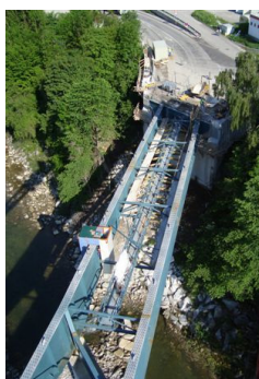
Objekt B121.07, Ybbsbrücke bei Böhlertwerk.
