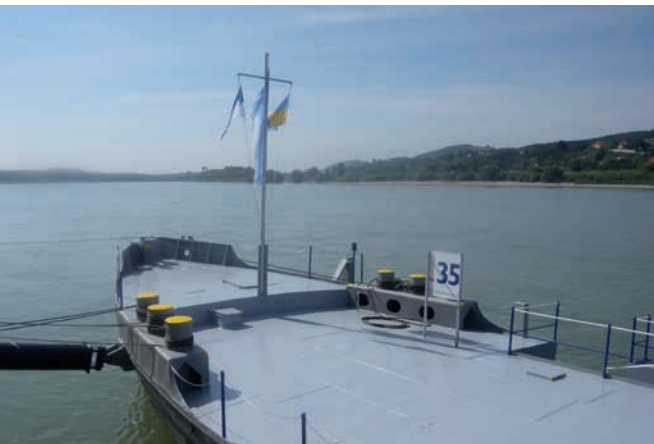
2008 wurde in Melk eine zusätzliche Schiffsanlegestelle für die Kabinenschifffahrt gebaut.
