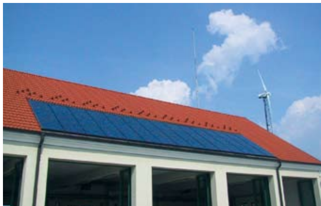
Links: Photovoltaikanlage der Straßenmeisterei Zistersdorf
