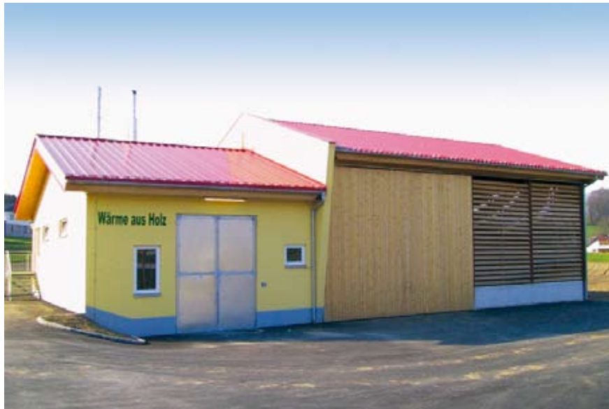
Biomasse Fernheizwerk Vestenthal
