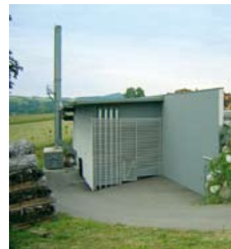
Biomasse Fernheizwerk Melk
