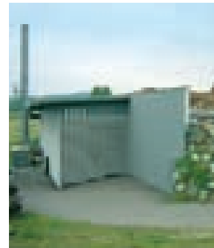
Biomasse Fernheizwerk Melk
