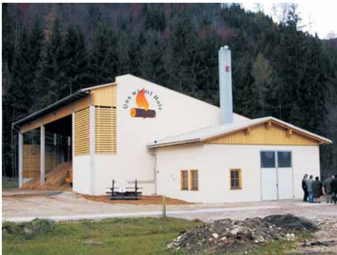
Biomasse Fernheizwerk Hohenlehen
