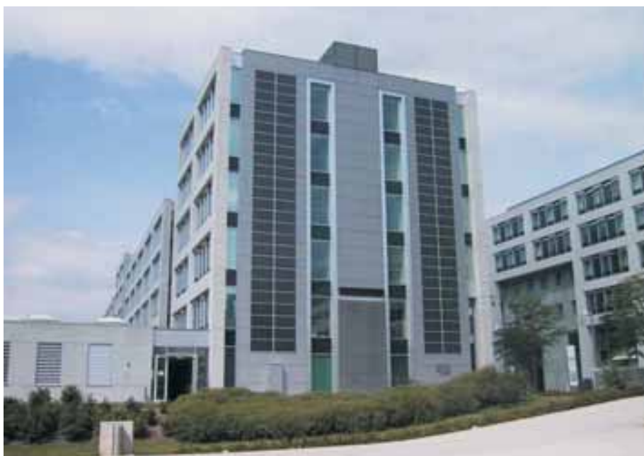
Photovoltaikanlage NÖ Landhaus St. Pölten
