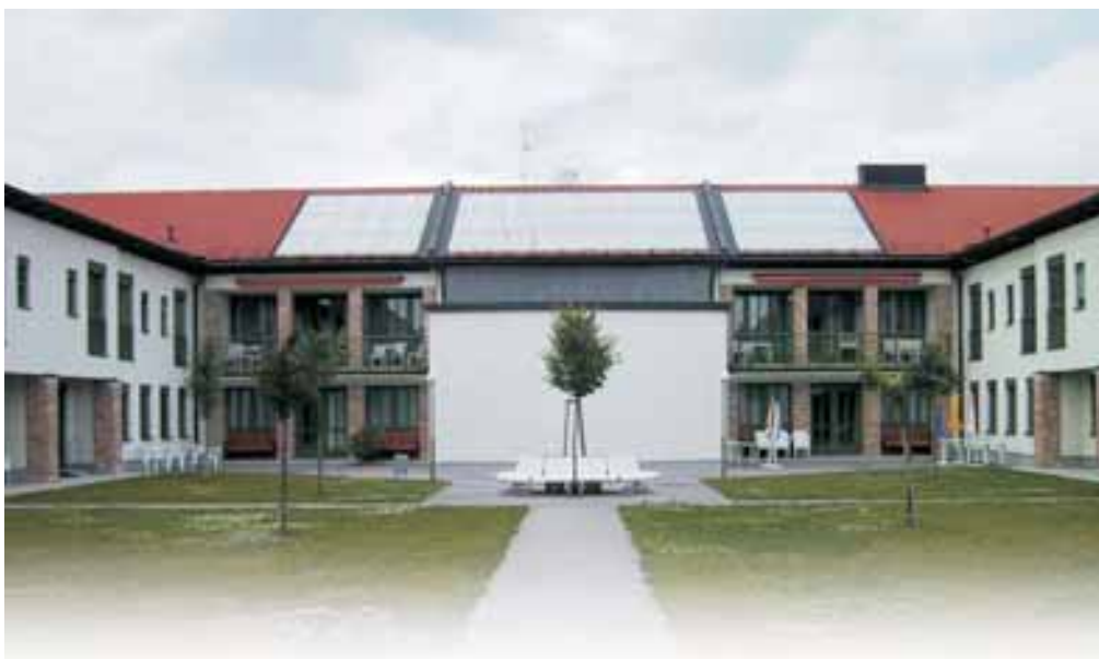
Solaranlage Landespensionistenheim Laa/Thaya
