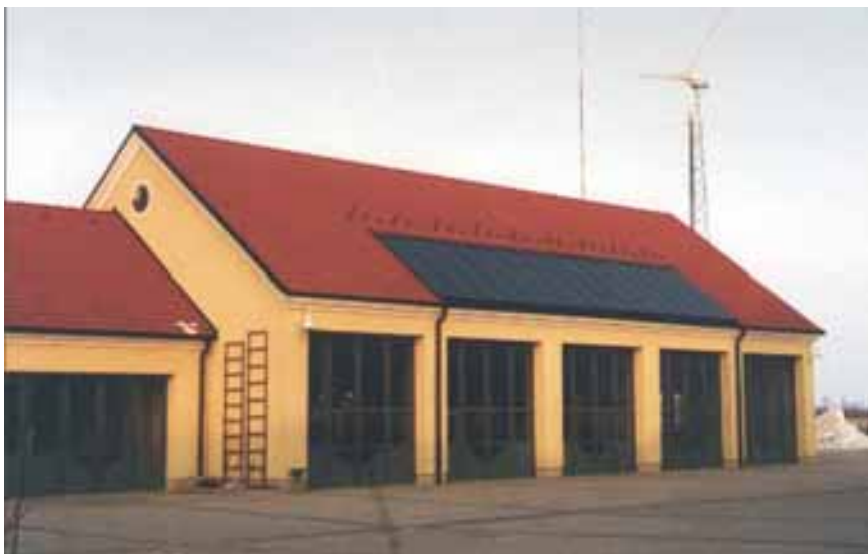
PV - Anlage der Straßenmeisterei Zistersdorf
