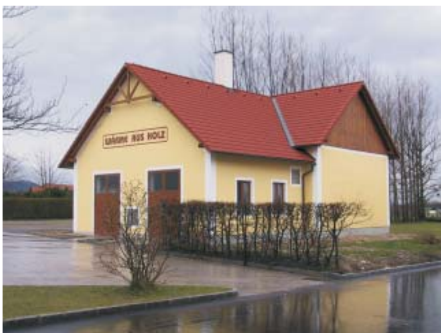
150. Biomasseheizwerk in NÖ (Euratsfeld)
