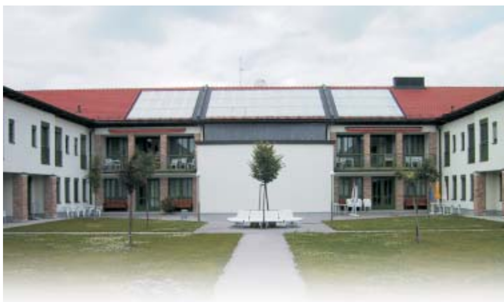
Solaranlage Landespensionistenheim Laa/Thaya
