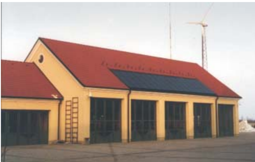
PV - Anlage der Straßenmeisterei Zistersdorf
