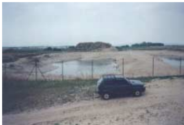
Versuchsanlage für die Grundwasseranreicherung am Standort Stallingerfeld
