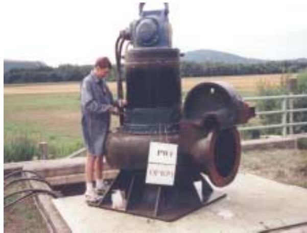
Revision einer Pumpe am unteren Rußbach
