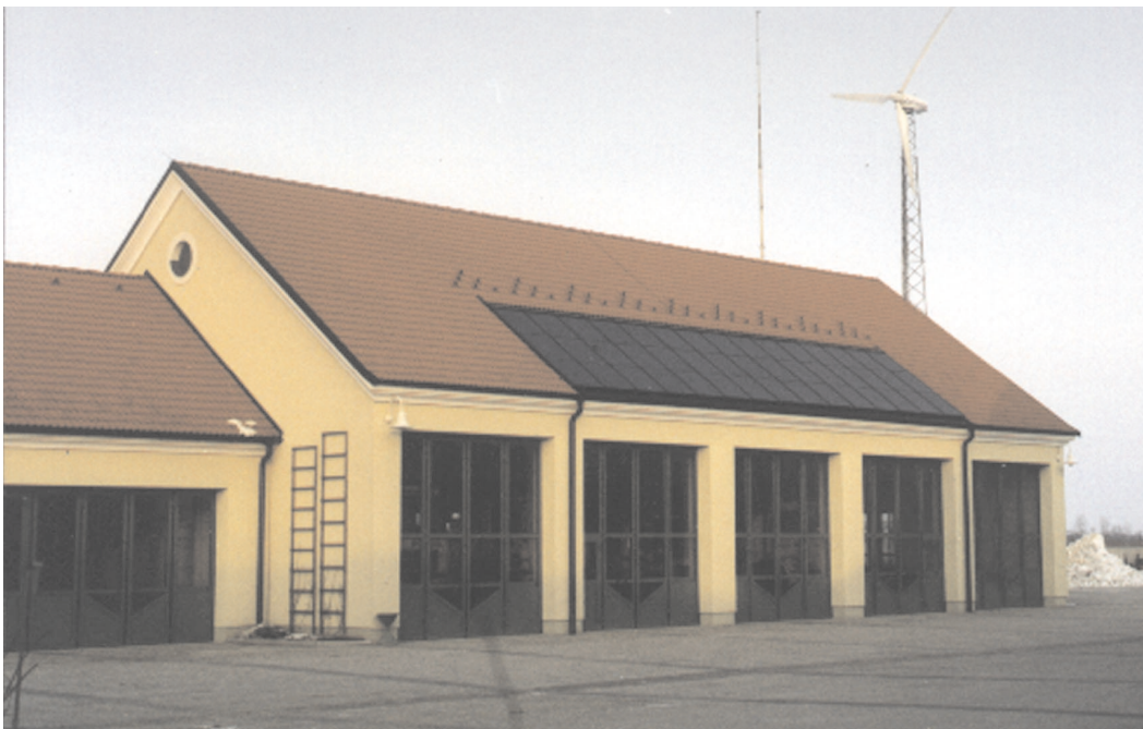
PV - Anlage der Straßenmeisterei Zistersdorf
